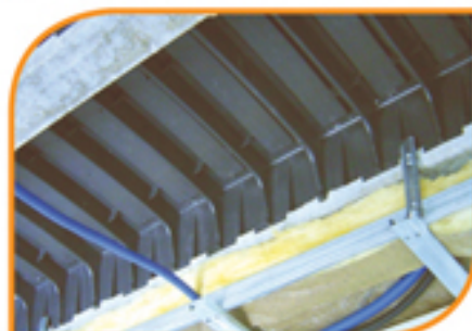
element stropu zrealizowanego z RAPIDO widok od dołu
